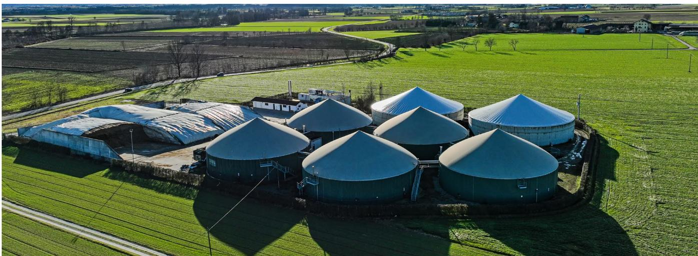
Si parla di digestione A SECCO quando la biomassa ha un contenuto solido minimo del 30%. Si definisce invece digestione A UMIDO se la biomassa ha un contenuto un contenuto solido del 10-15%.
